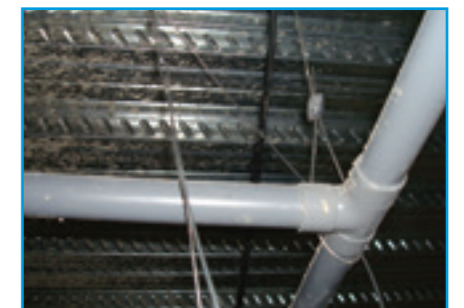
Condensate pipes
